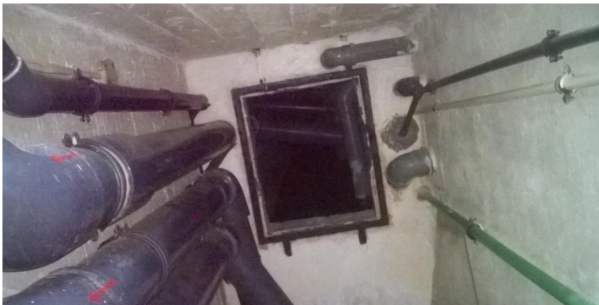
1. Dokumentacja fotograficzna. Właz do zbiornika
